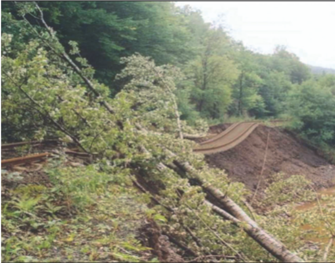
Abbildung 2: Bahnstreckenabspülung
