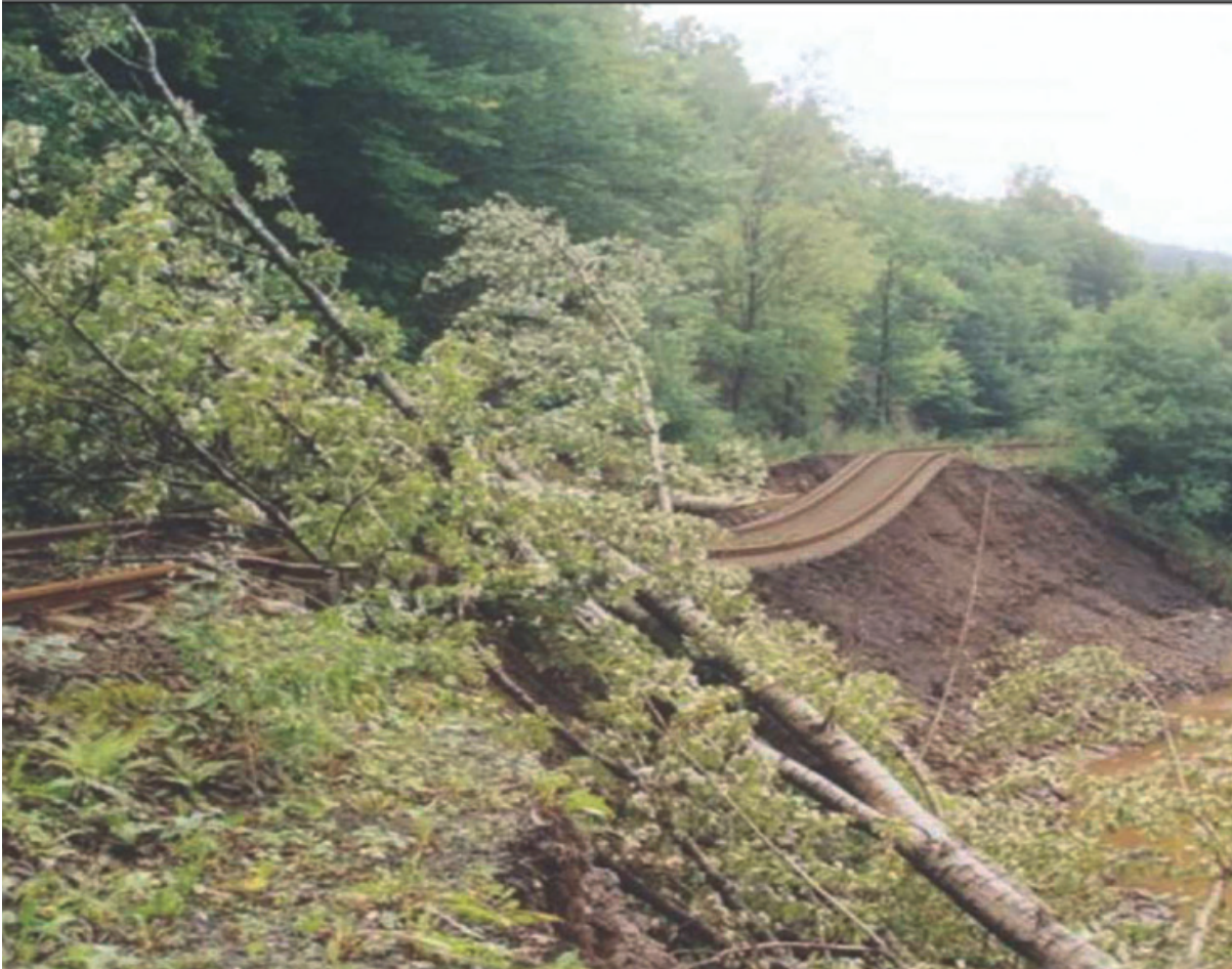
Abbildung 2: Bahnstreckenabspülung
