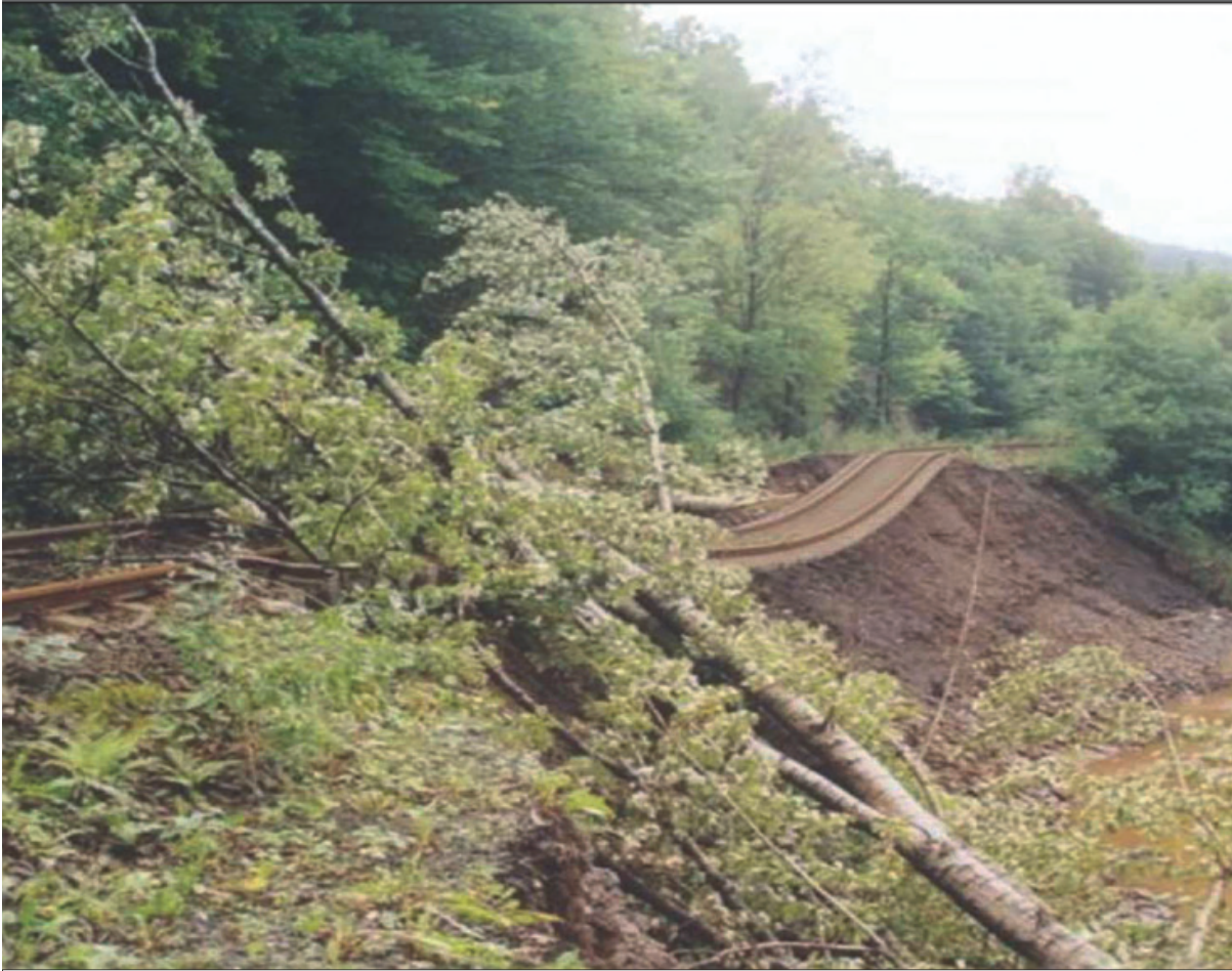
Abbildung 2: Bahnstreckenabspülung
